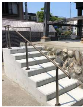
鐘楼堂の階段修理
